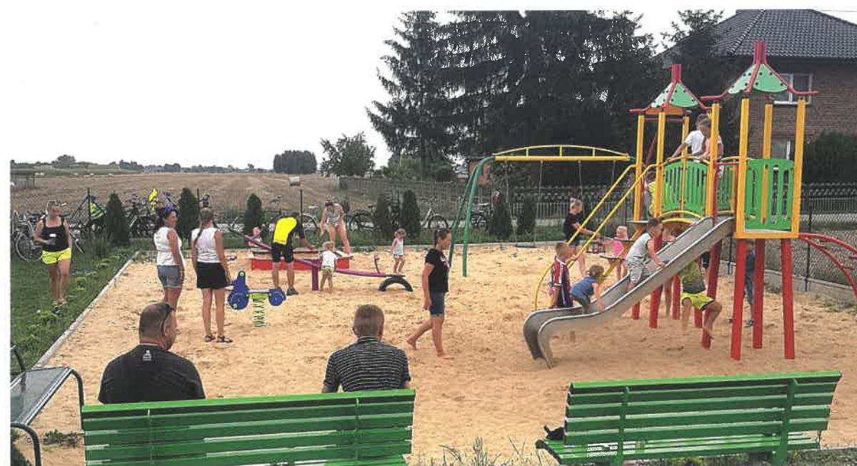
Budowa placu zabaw w Bożatkach „Pięknie wielkopolska wieś” 2018
