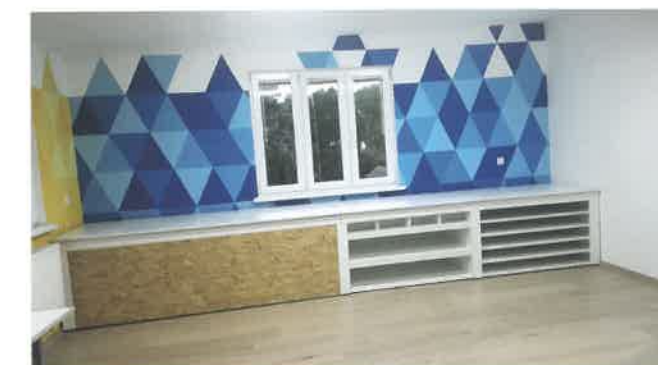
Modernizacja pomieszczenia w Domu Kultury w Sławsku „Nasza wieś, naszą wspólną sprawą” 2018
